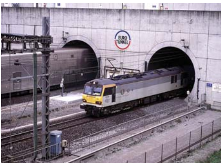
지하터널 철도 케이블
